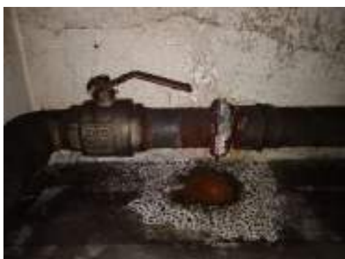
Instalação predial – Fuga em ramal
