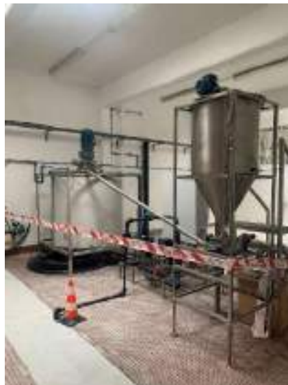
Sistema de preparação e doseamento de carvão ativado
