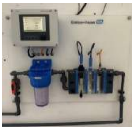
Analizador de cloro residual e pH à saída da ETA
