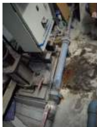
Instalação predial – Fuga no grupo de bombagem
