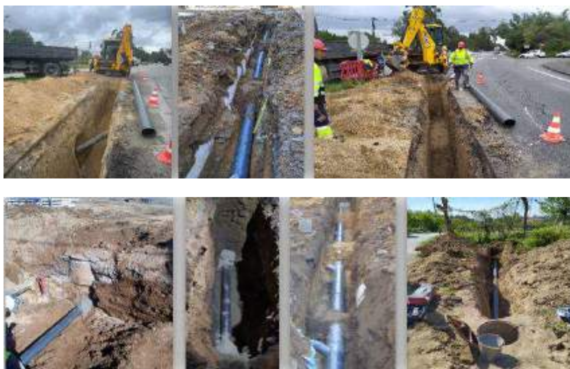
Obras de execução e reparação de coletores e ramais
