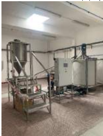
Sistema de preparação e doseamento de carvão ativado
