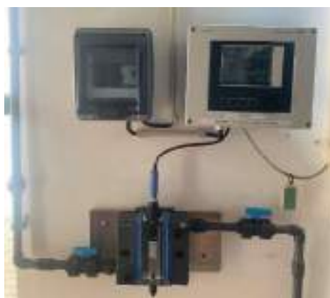
Analizador de cloro de entrada da ETA
